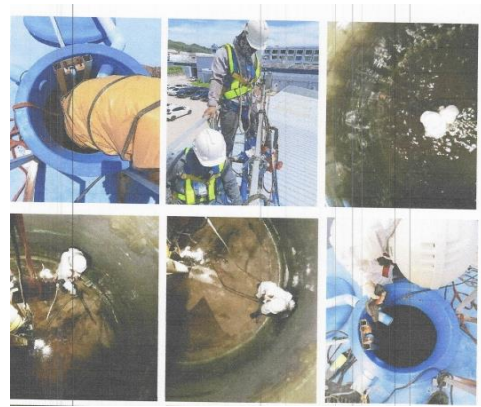
รูปที่ 3-19 ทำความสะอาดบ่อเก็บน้ำสำรอง
