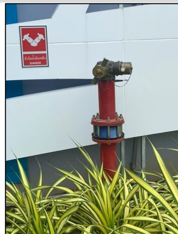
หัวรับน้ำดับเพลิง ขนาด FDC. 4"X | 2 1/2"X | 2 1/2" นิ้ว พร้อม Check Valve หัวสวมเร็วและฝาปิด
