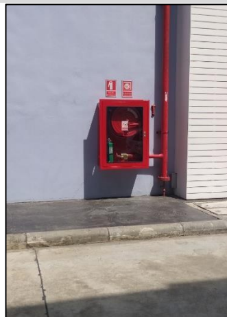
เก็บสายฉีดน้ำดับเพลิงพร้อมอุปกรณ์ (Fire Hose Cabinet: FHC)
